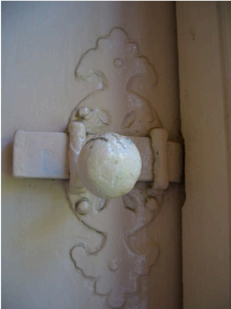
Vue détaillée d'un loquet du logis.
