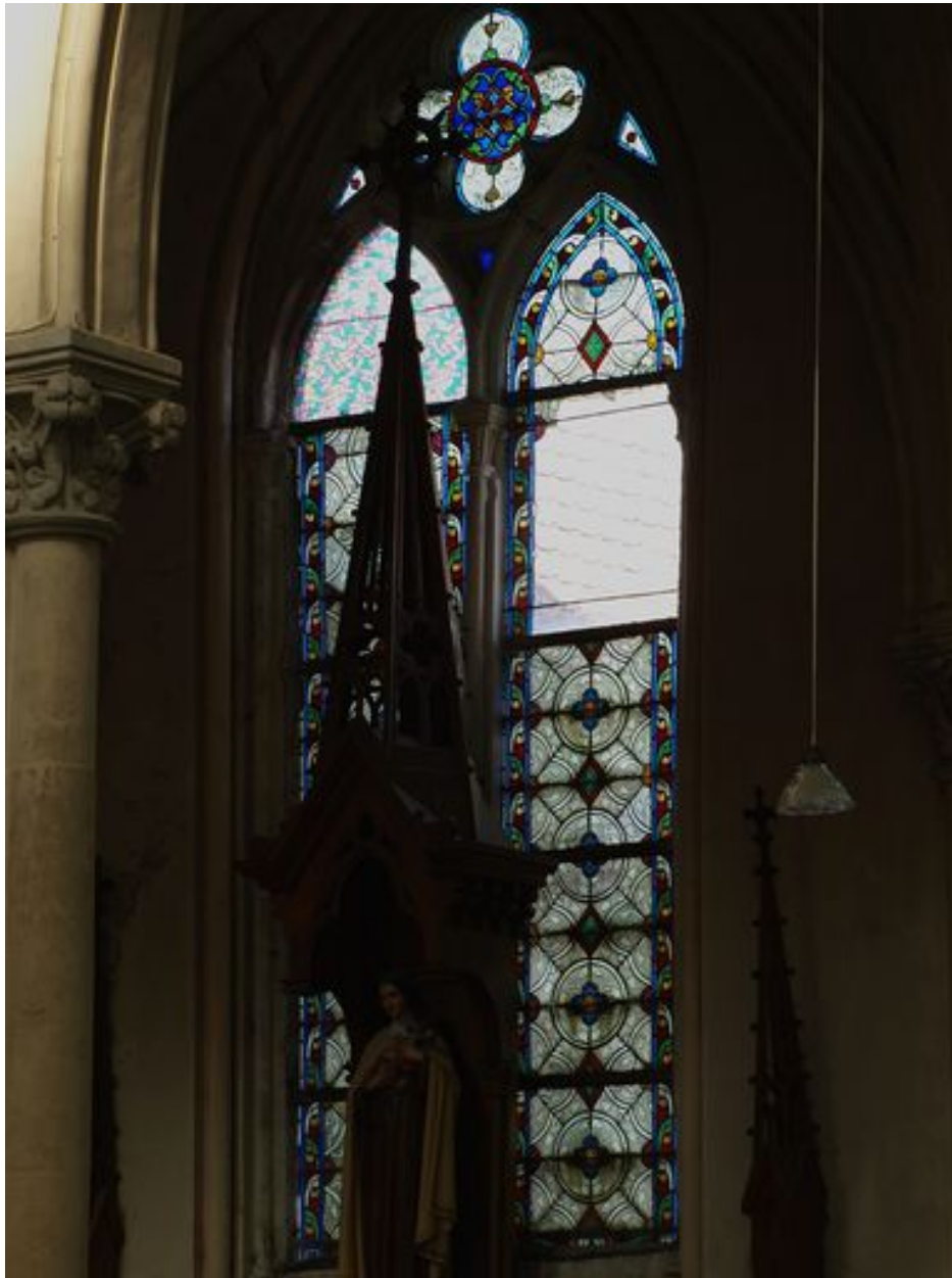
Baie des bas-côtés : panneaux manquants (baie 19)
