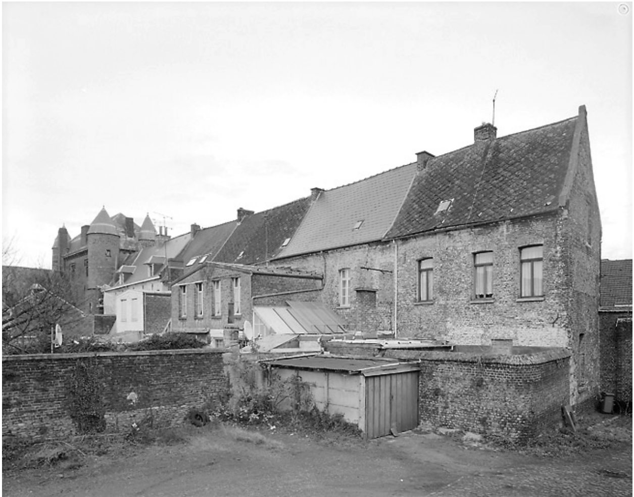
Aile de la rue de la Cavalerie : vue arrière, du n° 27 vers le n° 37 et le corps de bâtiment médiéval, état en 2001.
