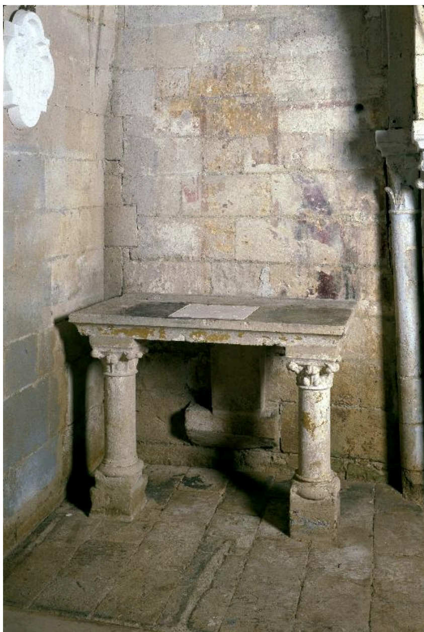
Vue de l'autel en cours de restauration (2001).
