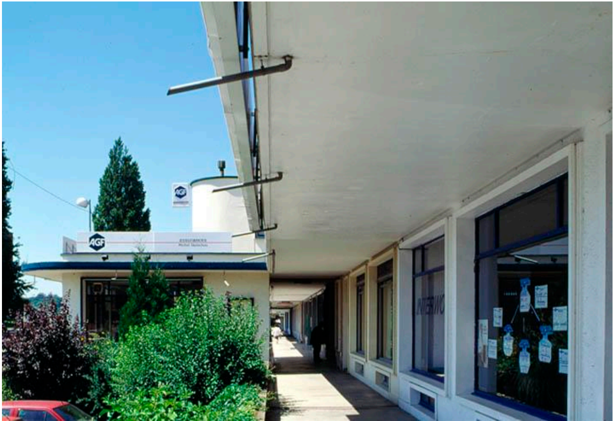
Vue de détail : le portique.
