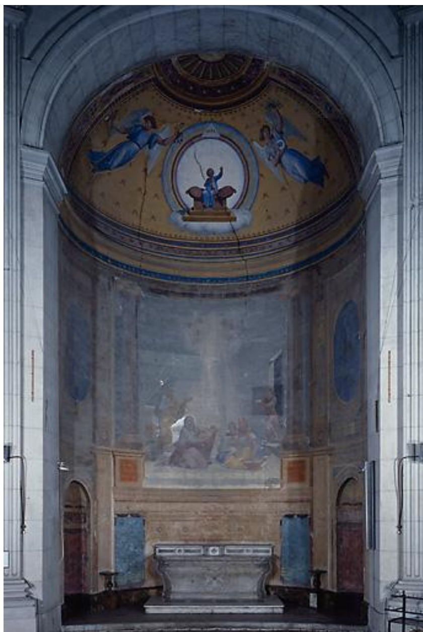
Vue générale, avant restauration.
