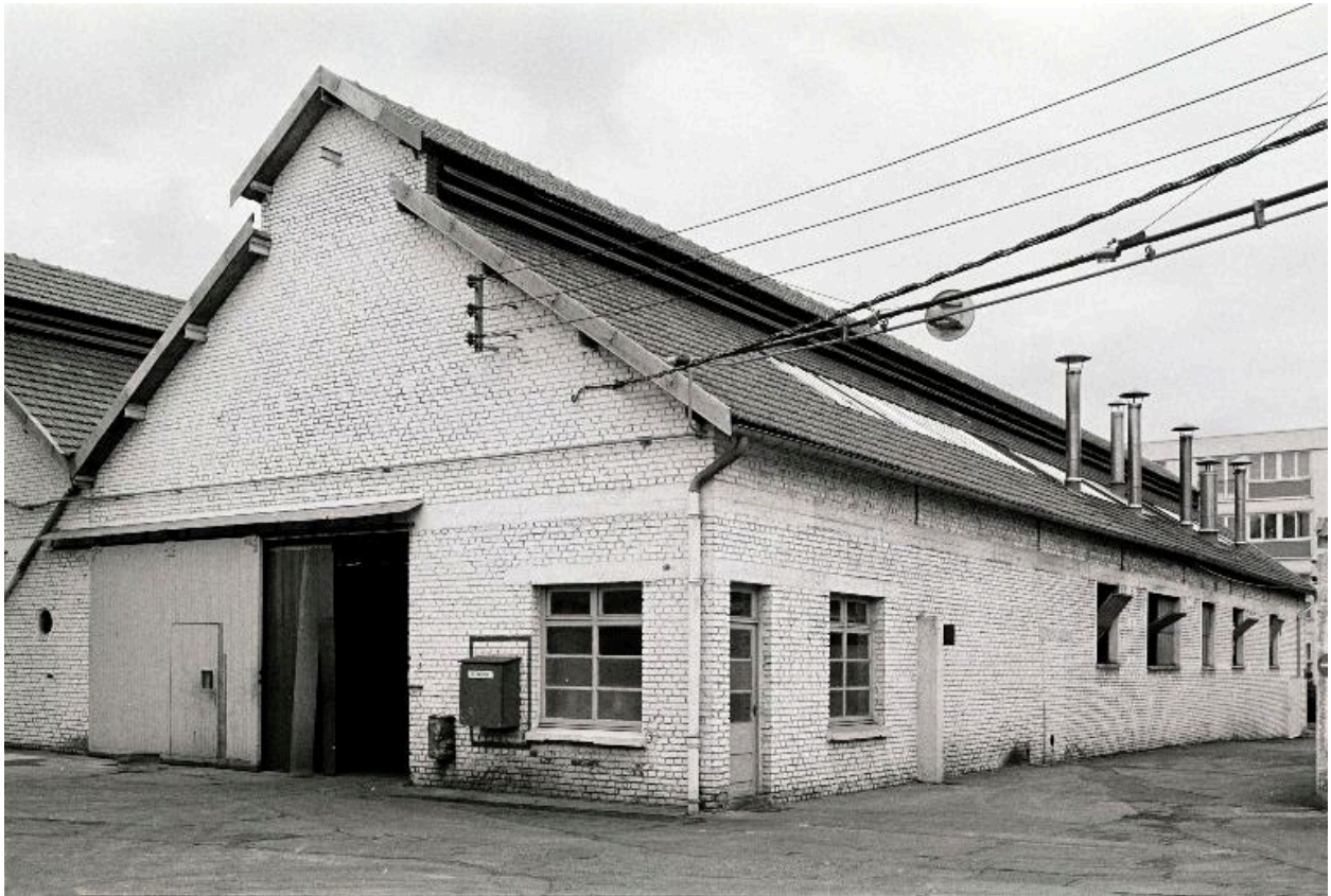
Atelier de fabrication (1960), vue postérieure en 1990.
