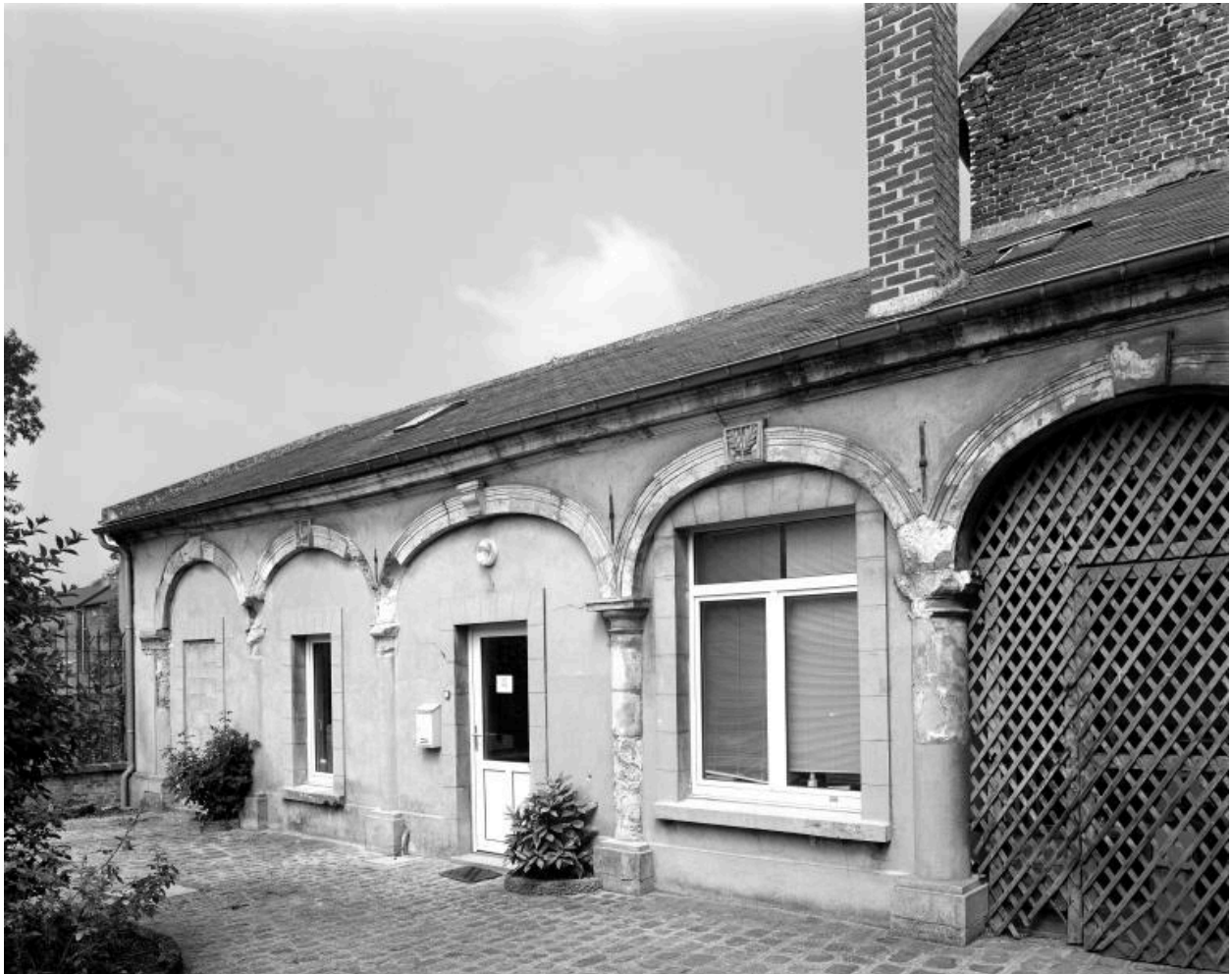
Vue de la cour arrière montrant l'ancienne remise.
