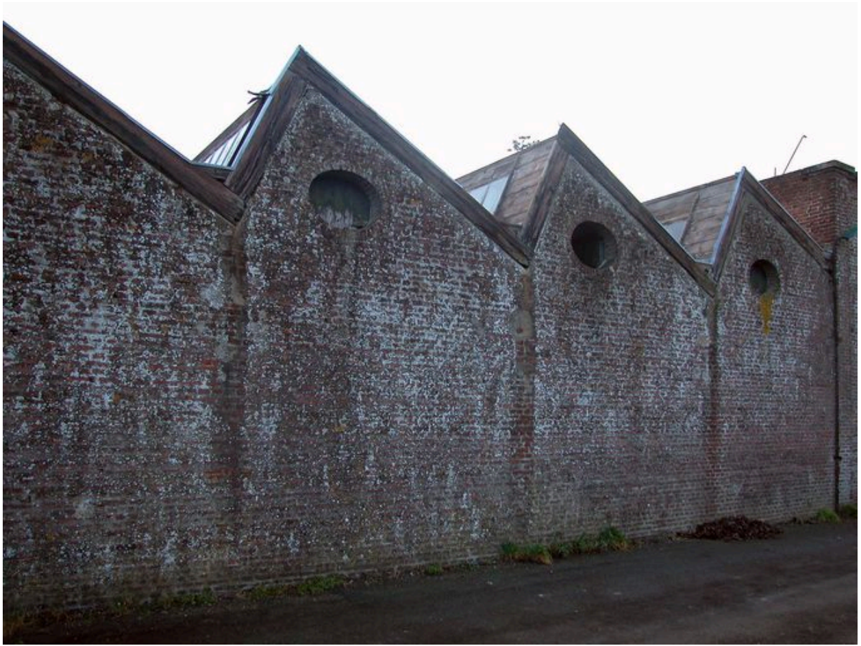
Détail des sheds des ateliers sur rue.
