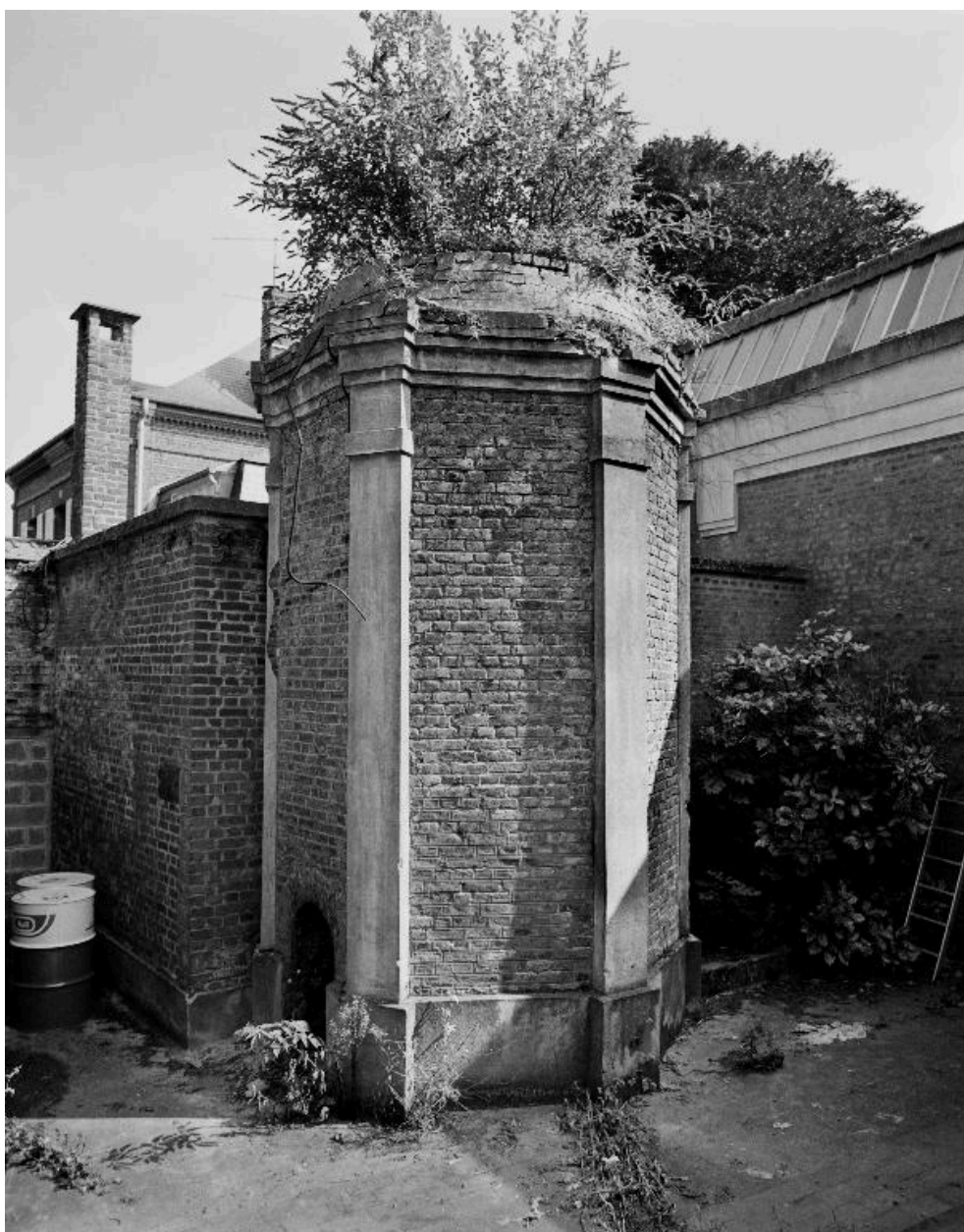
Cheminée d'usine, socle.
