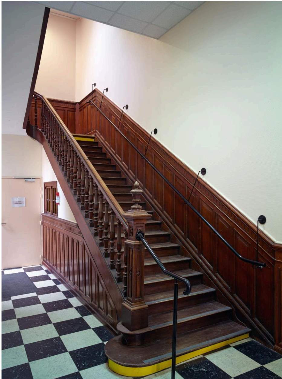
Escalier central tournant de l'aile de l'Horloge à volées droites et repos. Vue de la première volée.
