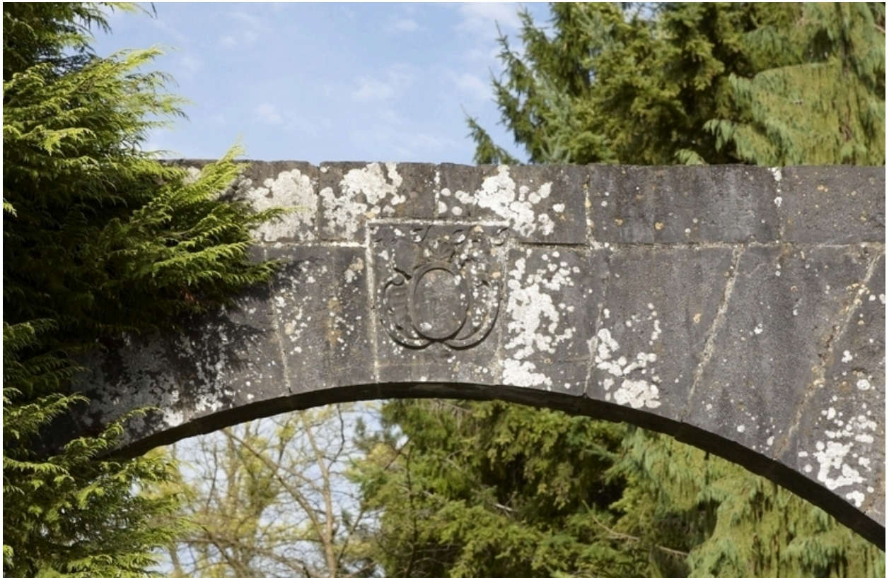
Détail de la date et du blason portés sur le porche.
