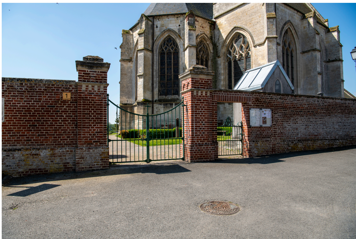
Vue générale de nord du cimetière.
