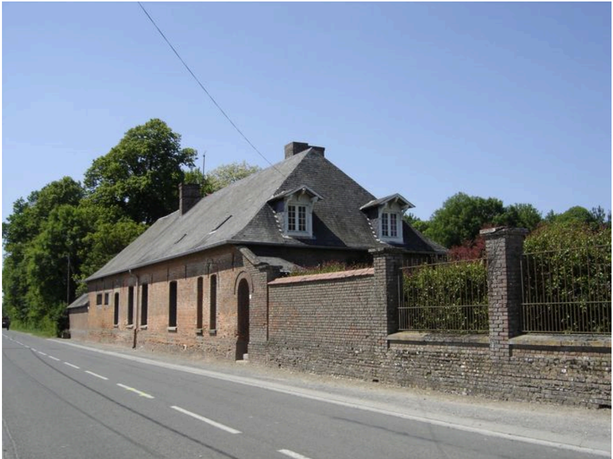
Vue des bâtiments sur rue.
