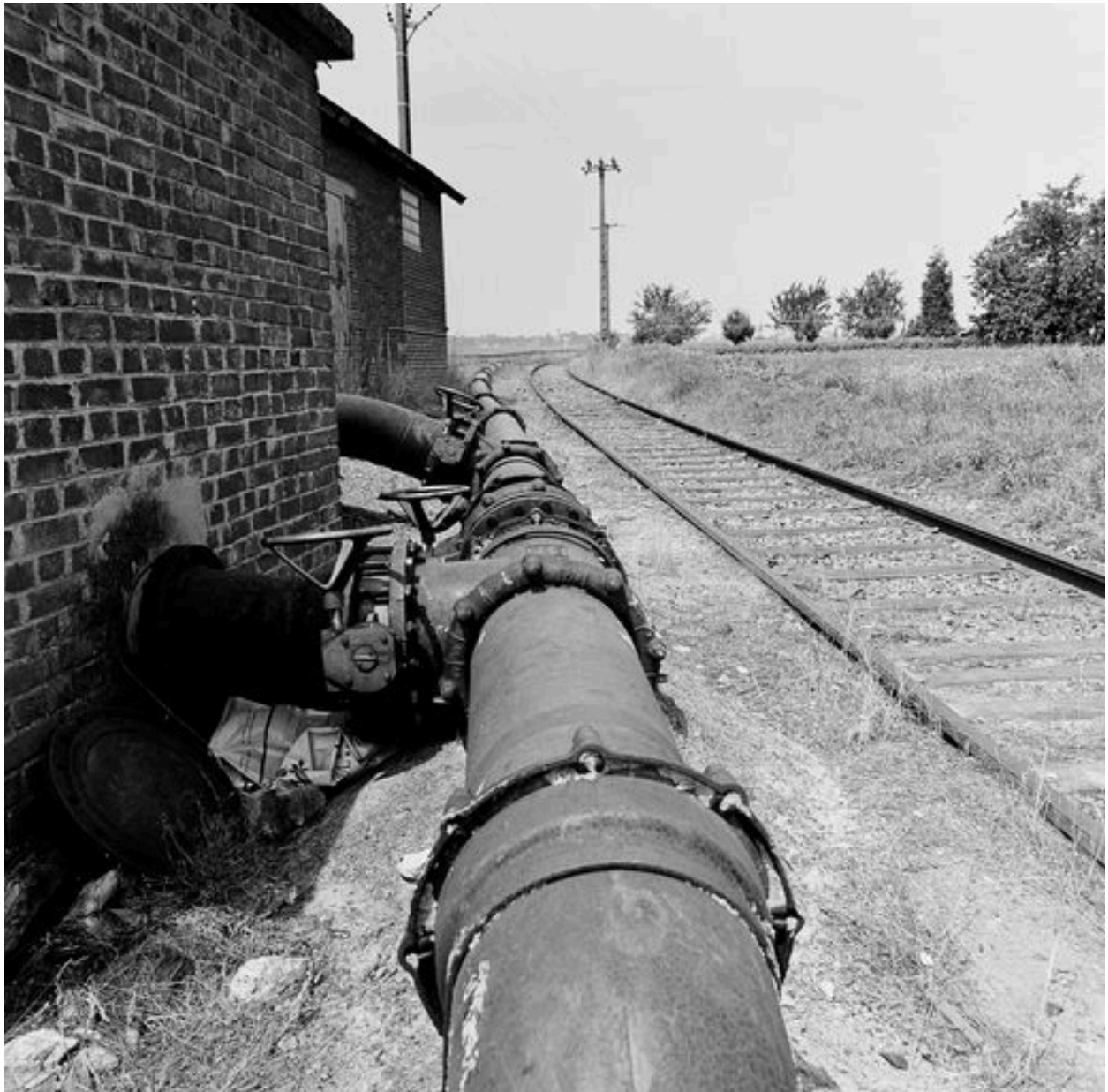
Station de pompage, canalisation vers l'usine.
