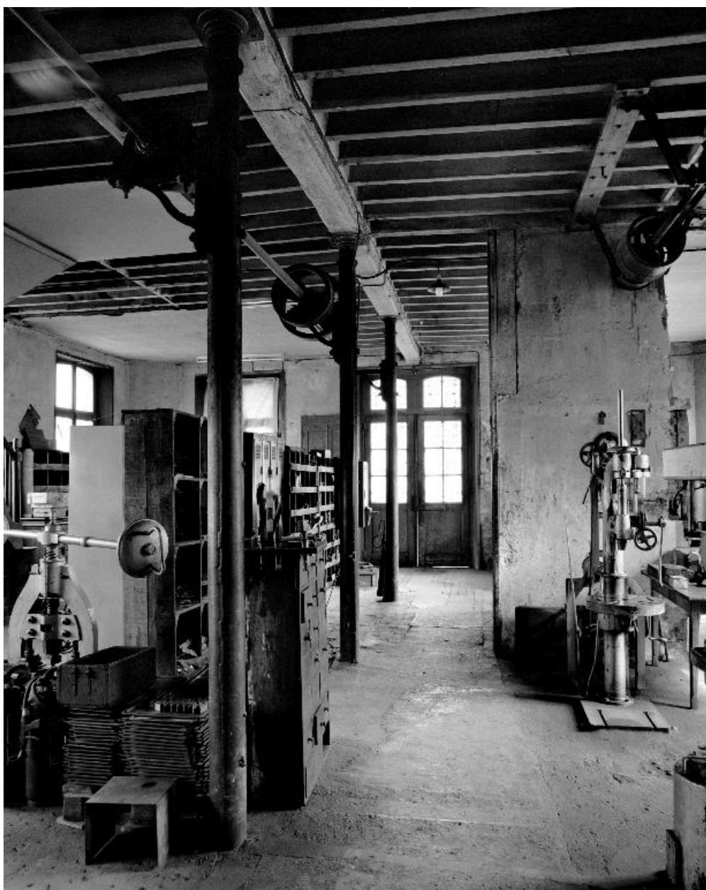
Atelier de fabrication, vue intérieure, en 1988.
