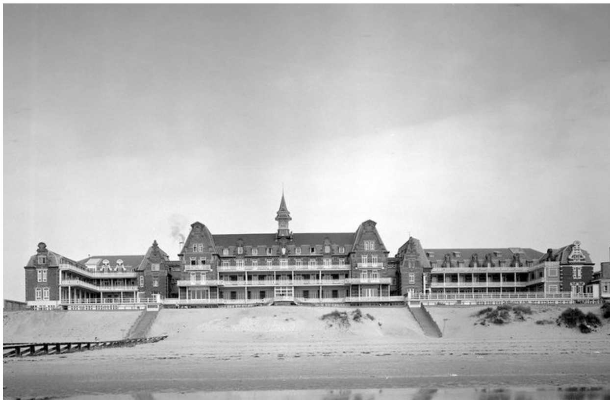
Bâtiments constitutifs de l'établissement primitif, élévations donnant sur la plage, vue d'ensemble prise de face.
