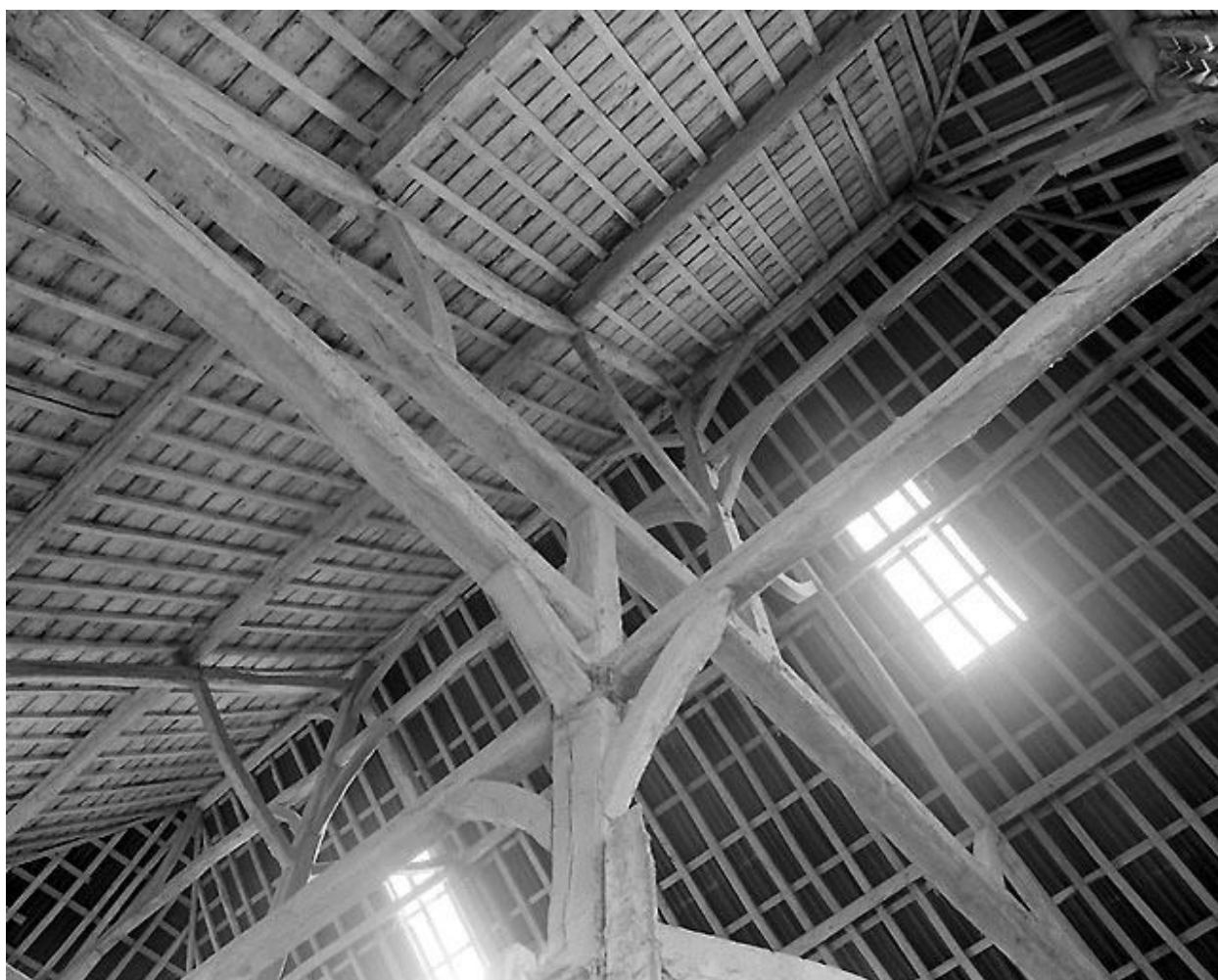
Grange : détail de la charpente et des faux-entrails.
