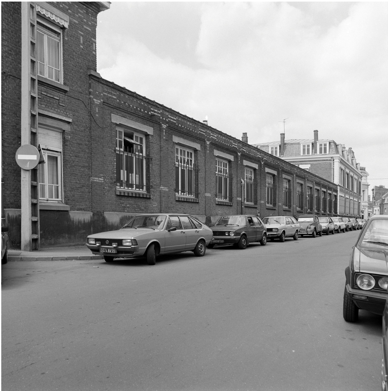
Élévation rue Jules-Ferry. Atelier de fabrication.
