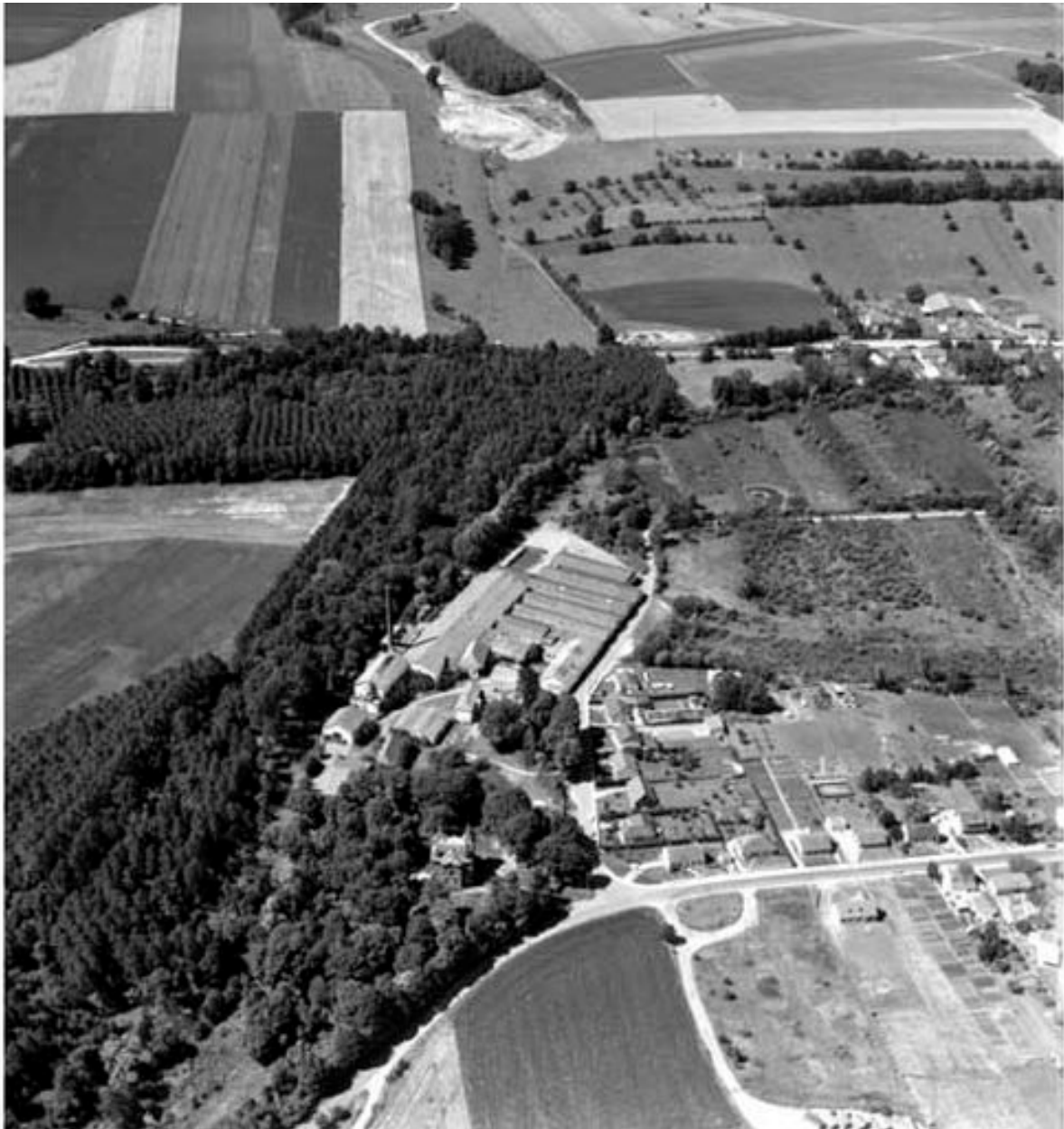
Vue aérienne, vue de l'est.
