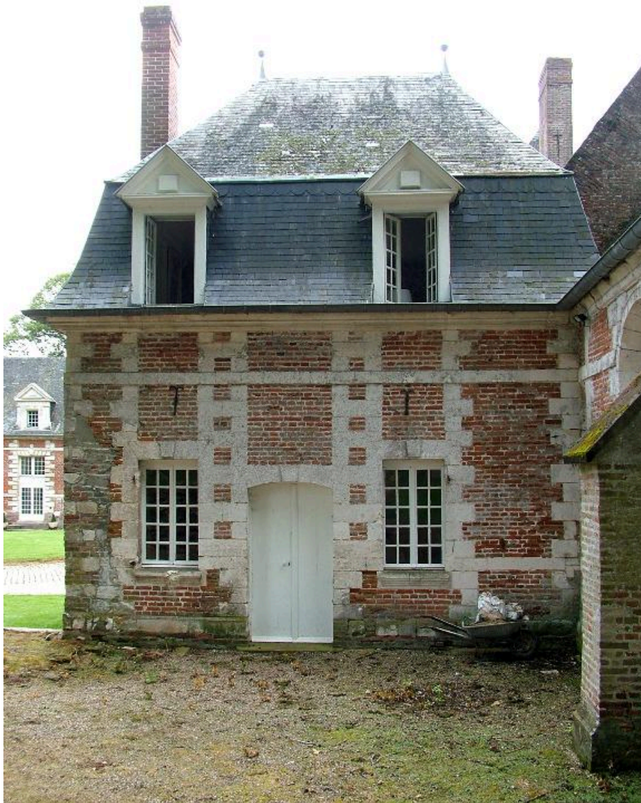
Elévation arrière du pavillon ouest perpendiculaire à la chapelle.
