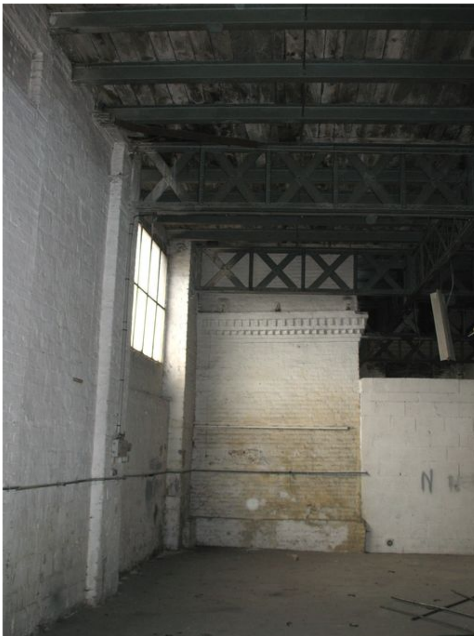
Base carrée de la cheminée au rez-de-chaussée.
