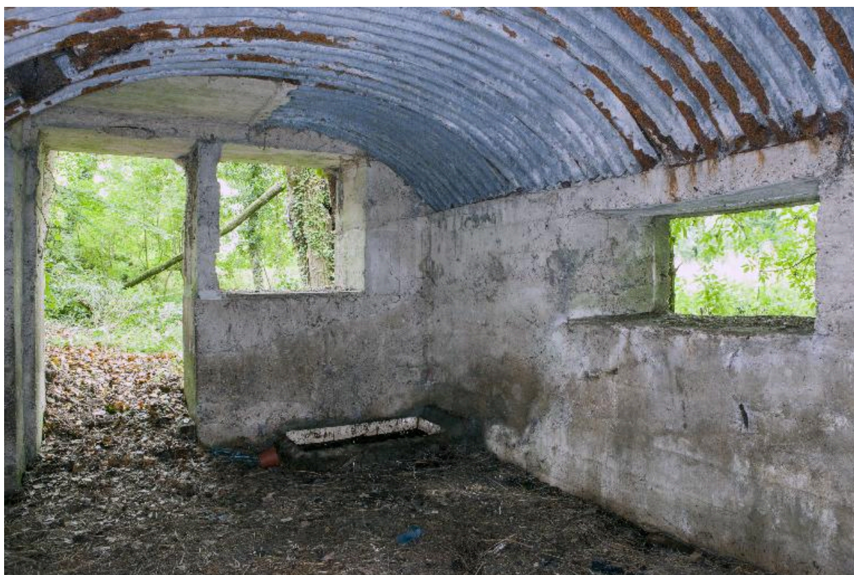
Casemate à personnel
