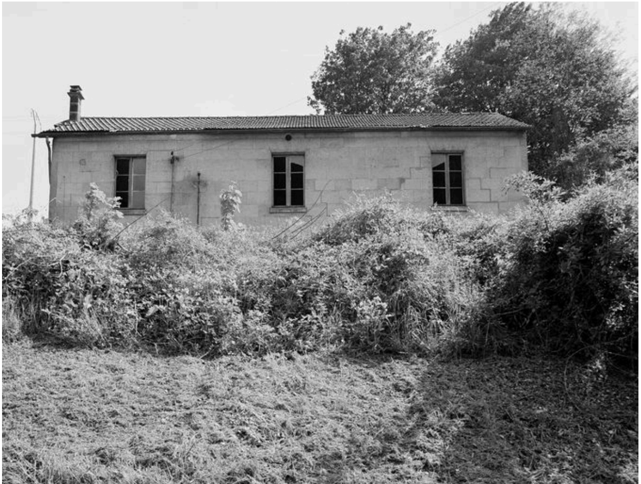
Logement d'ouvriers : façade nord.
