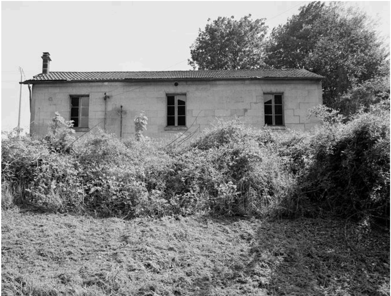
Logement d'ouvriers : façade nord.
