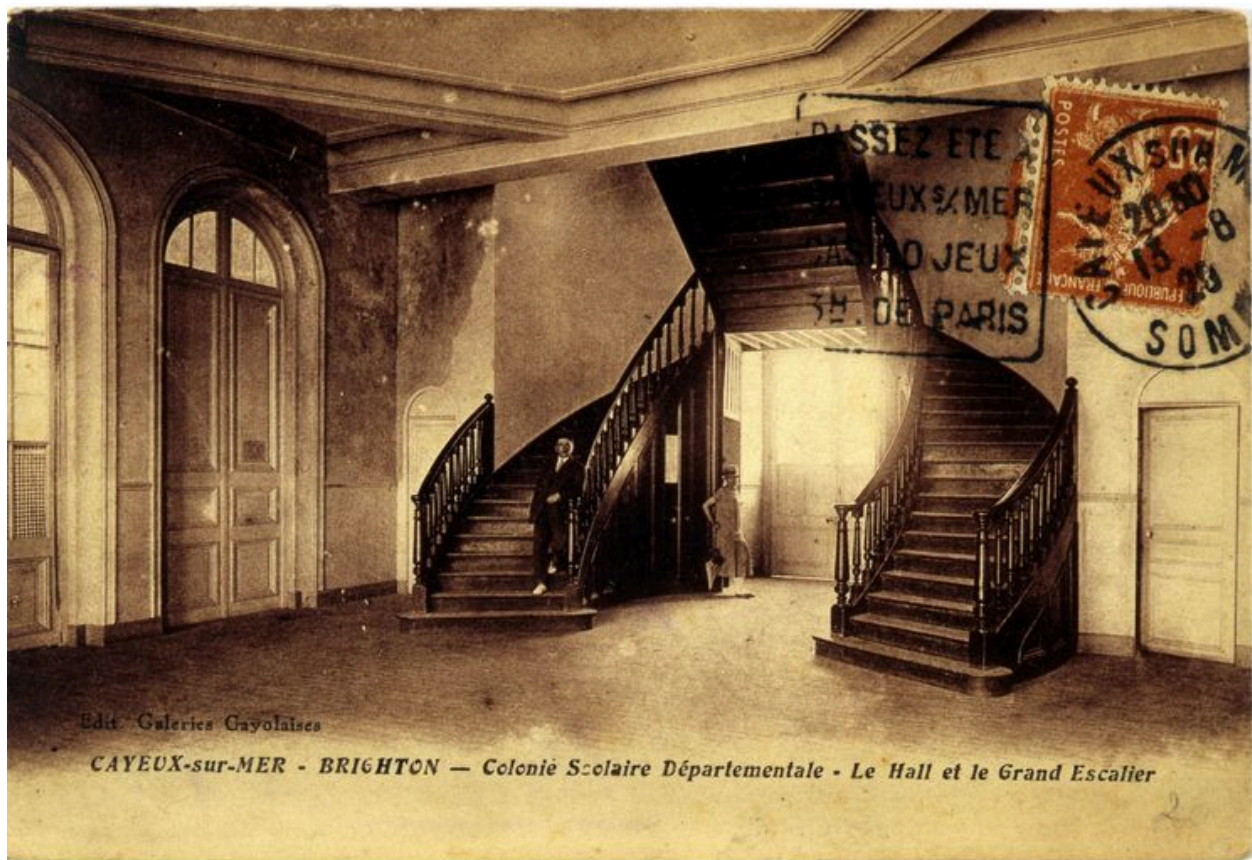
L'escalier de distribution intérieure, carte postale, 1er quart 20e siècle (coll. part.).
