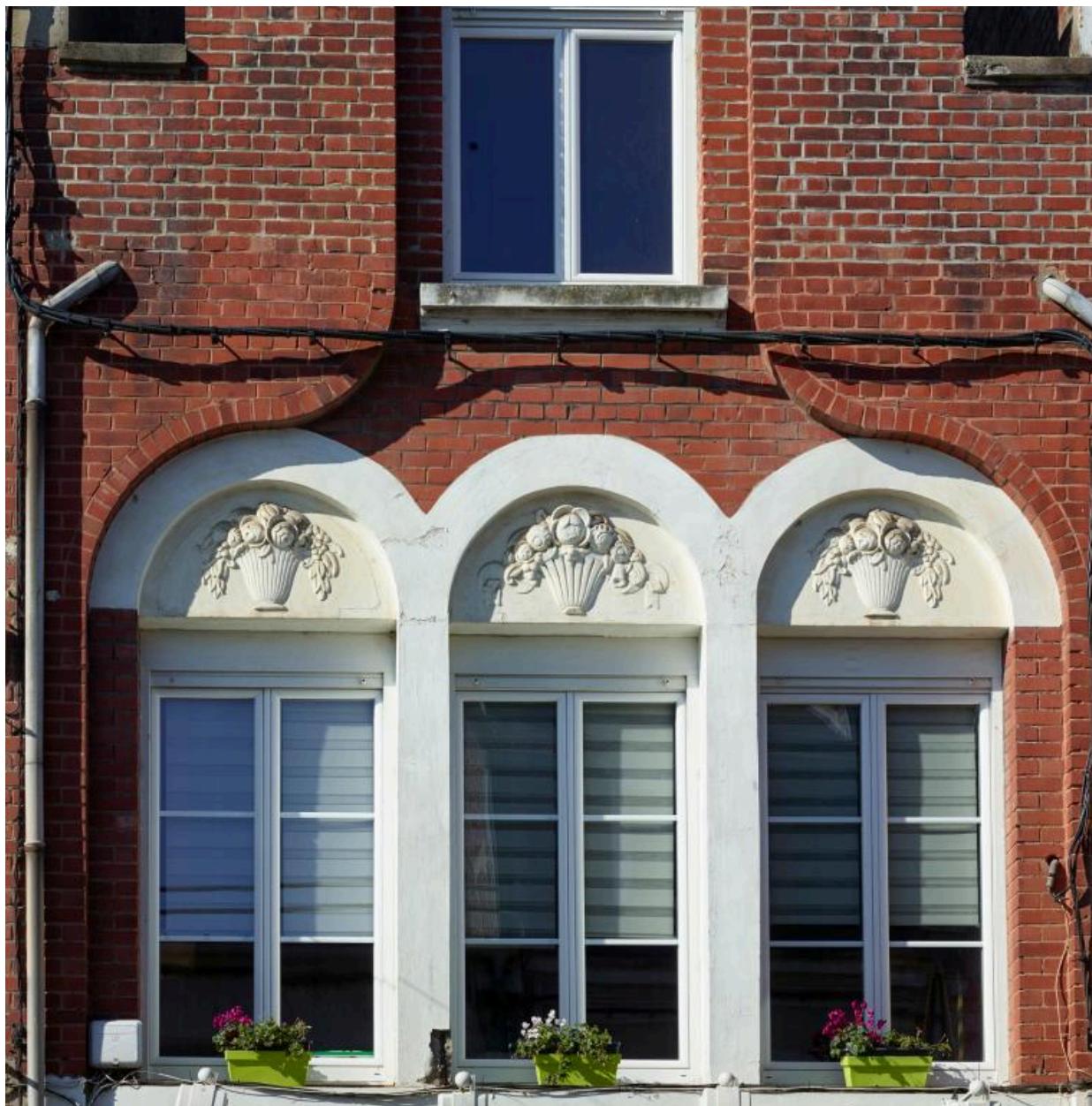
Maison à boutique, n° 51 rue de Péronne. Ancienne propriété de Mme Legay, construite par Paul Decaux en 1922. Détail du décor en béton moulé peint, à motifs de paniers de fleurs de style Art Déco, situés dans les tympans des baies géminées du premier niveau.
