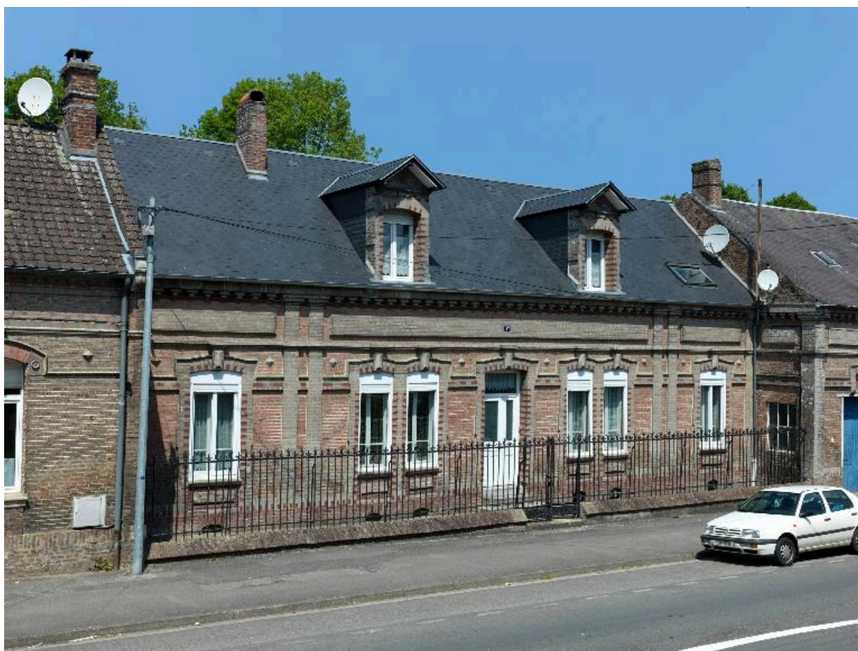
Façade sur rue de la maison.
