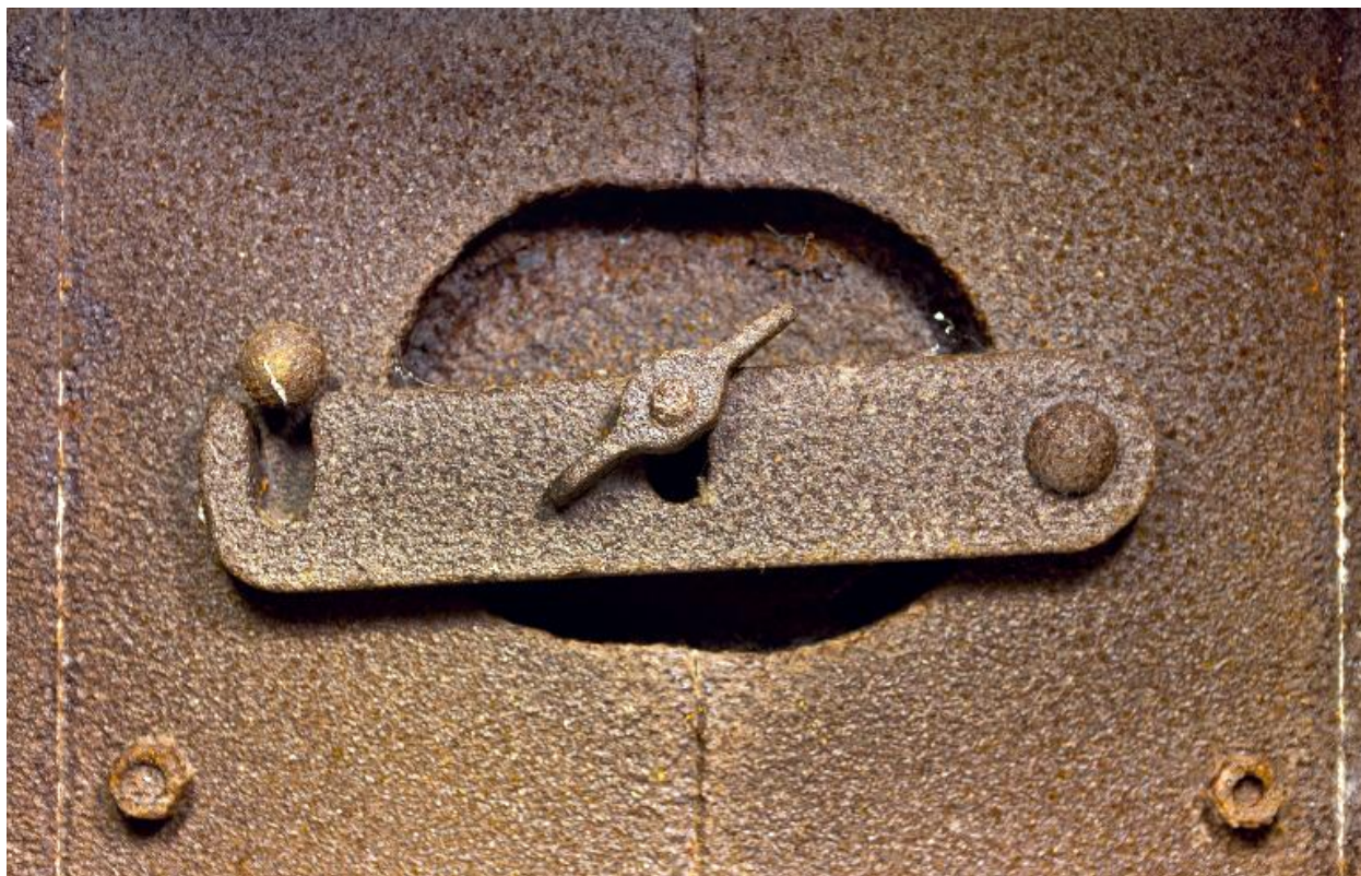
Observatoire casematé, dispositif de verrouillage.
