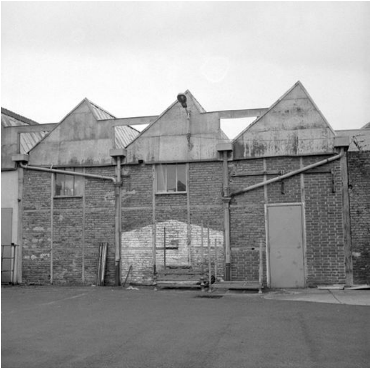
Atelier de fabrication, en 1990.
