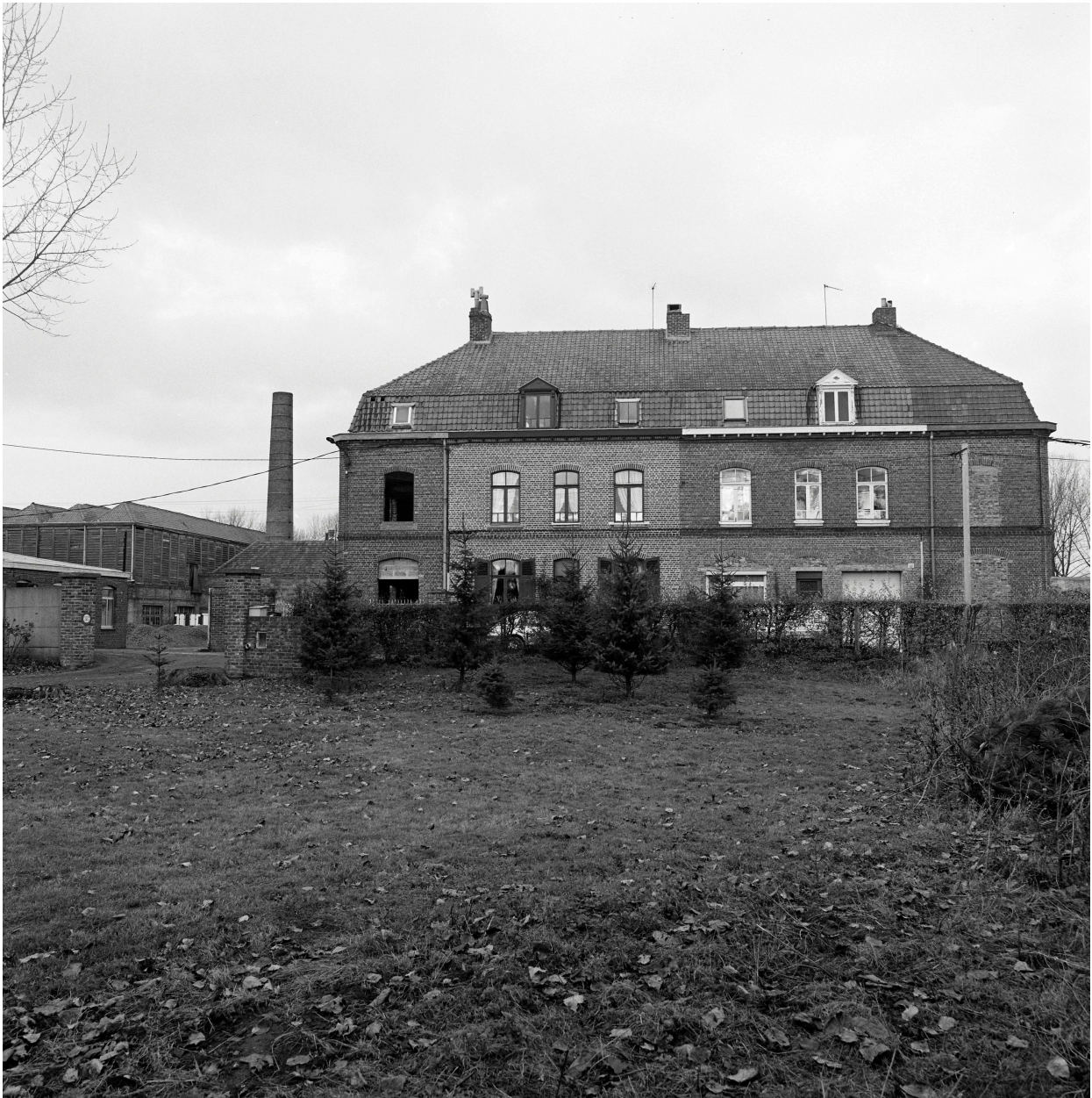
Logements de contremaîtres (bâtiment I).
