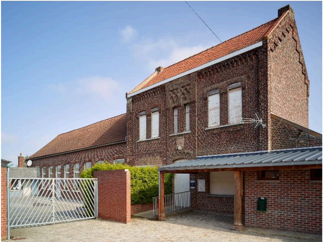
Vue générale des classes et de l'ancien logement d'instituteur.
