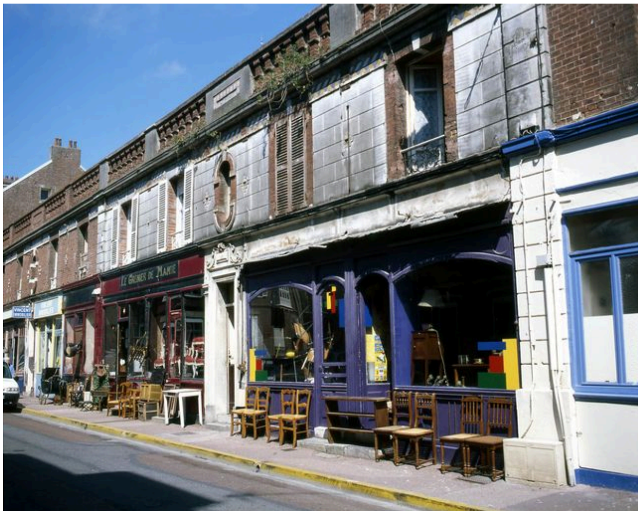
Détail d'une unité : 62, 64, 66, 68 rue Jules-Barni.
