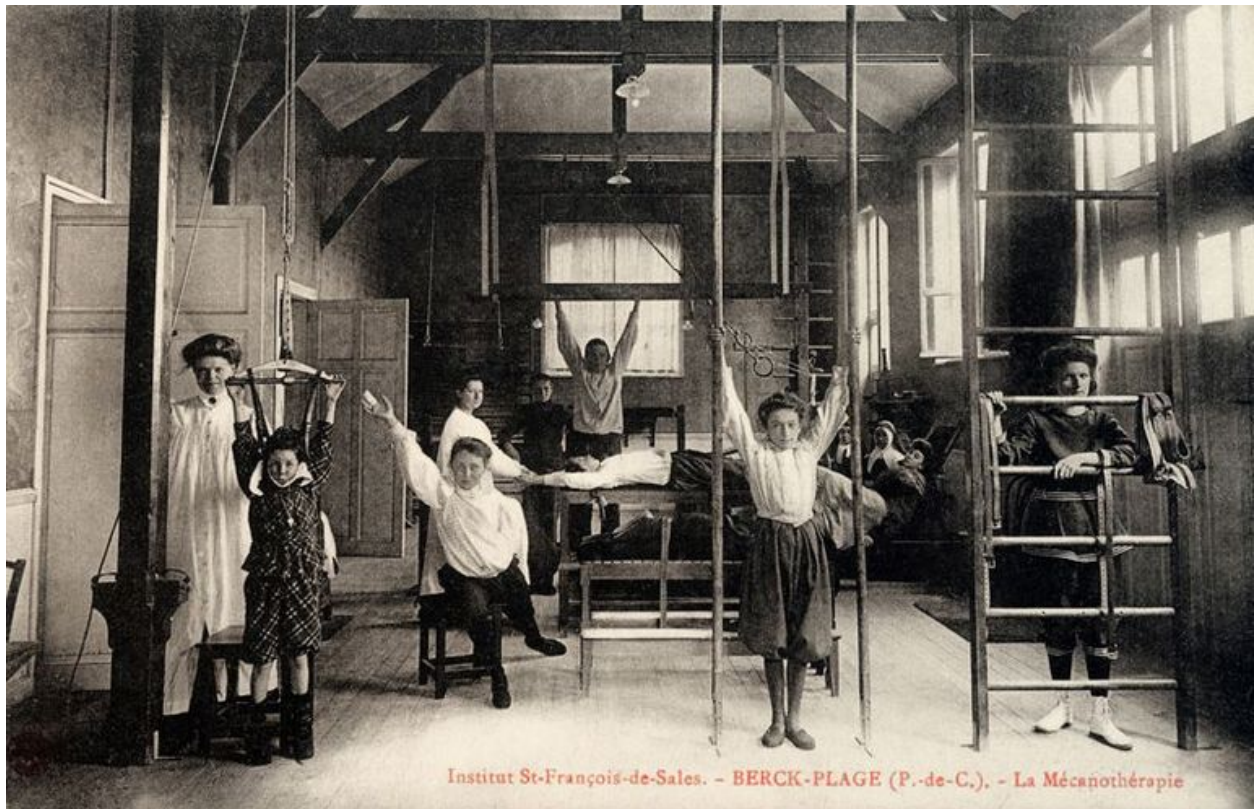
Bâtisse provisoire en bois abritant la salle de gymnastique et de mécanothérapie, vue intérieure montrant des filles occupées à des exercices de gymnastique orthopédique. Carte postale, début du 20e siècle (coll. part.).
