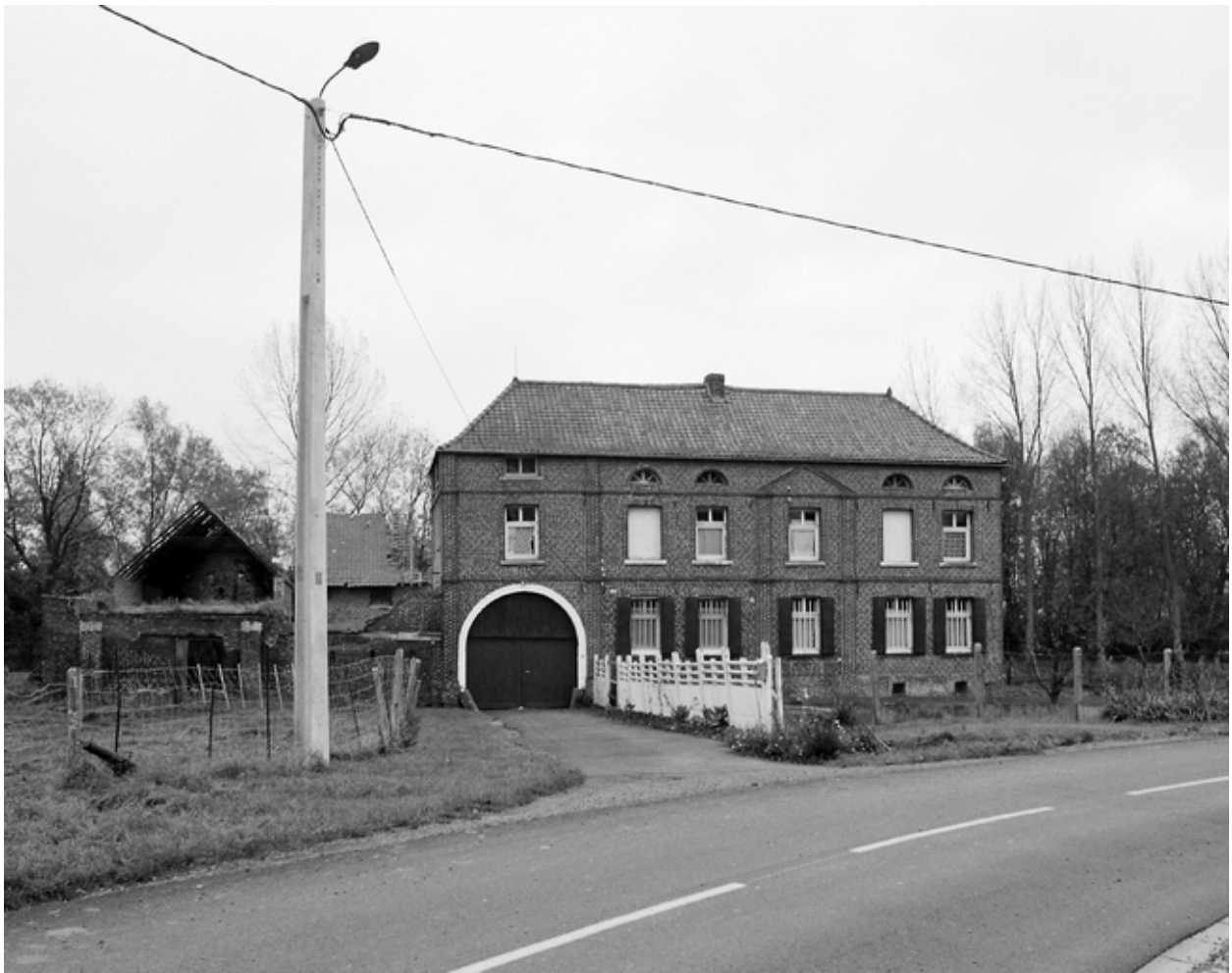
Ferme, 115, rue Morimetz, vue générale du logis.
