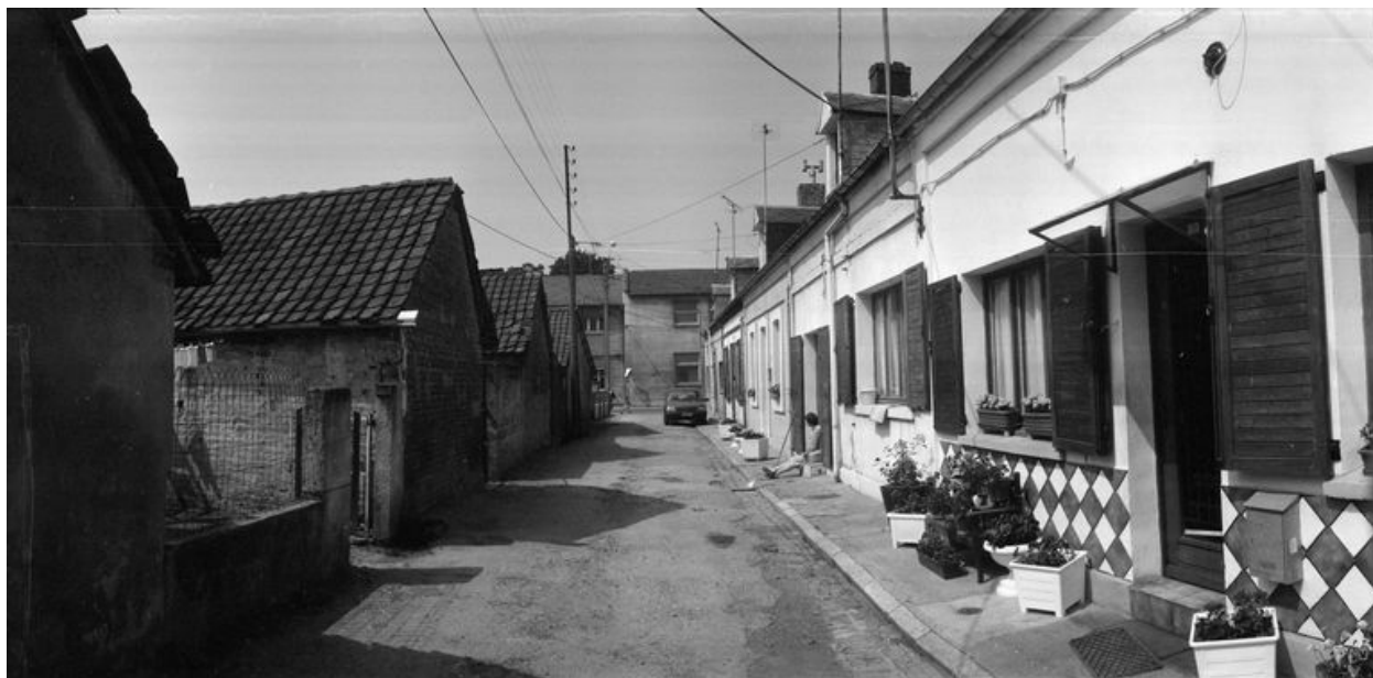
Logements d'ouvriers, en 1991.
