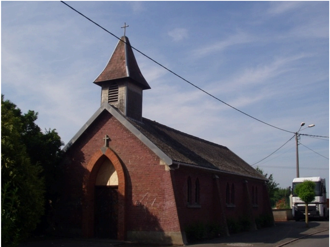
Vue de trois-quarts, vers le sud.
