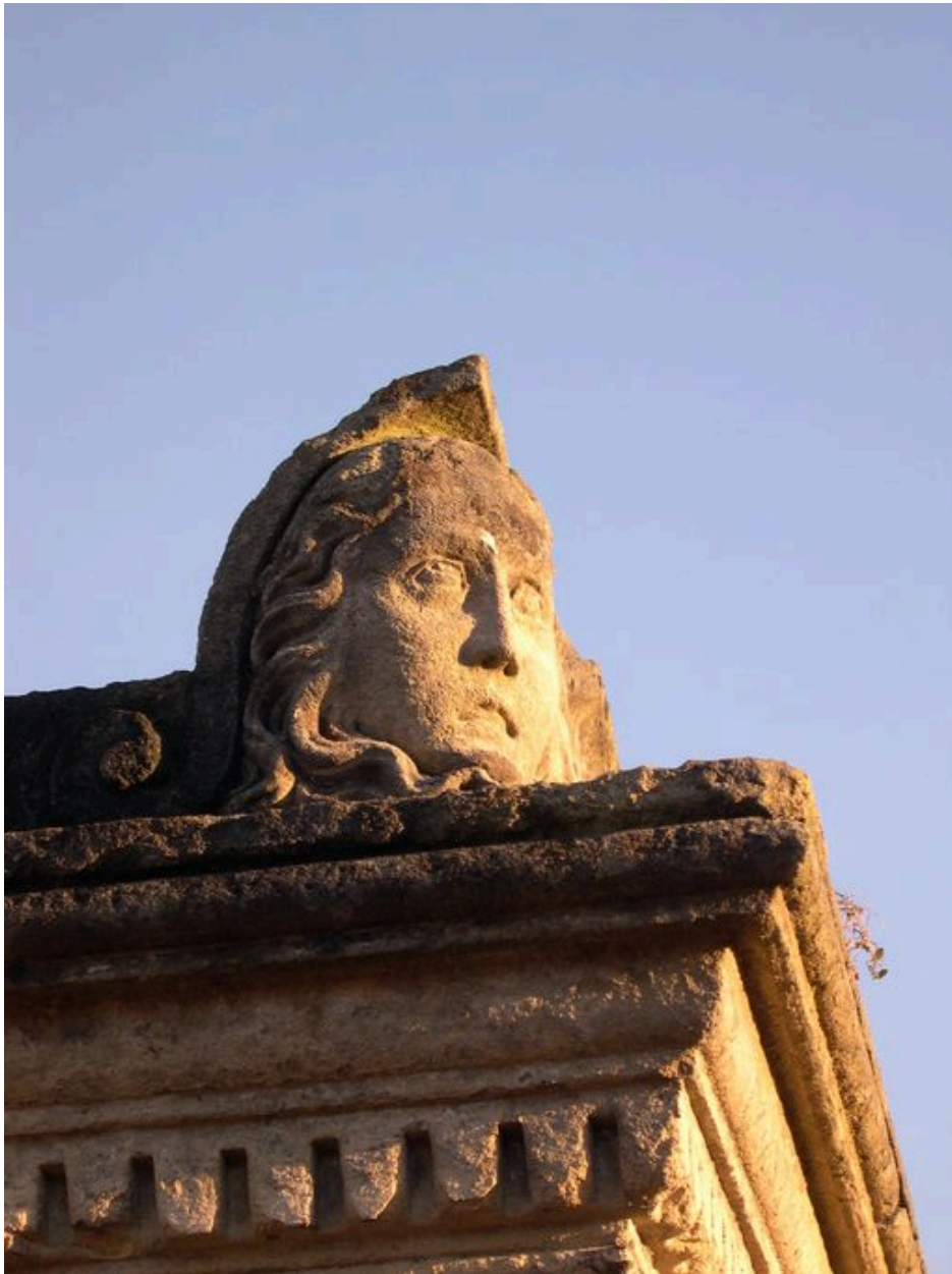
Vue de détail sur les acrotères
