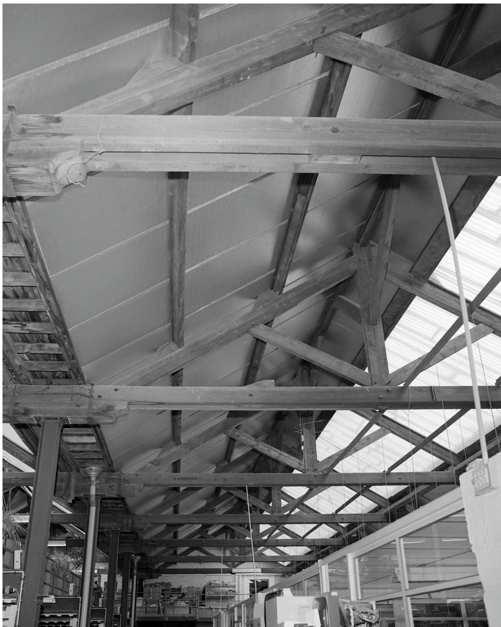
Atelier de fabrication. Vue de la charpente.
