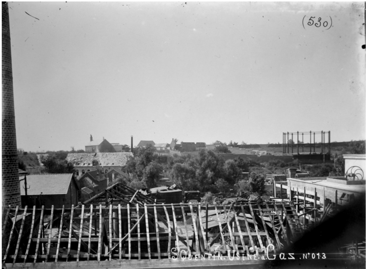
L'usine à gaz en reconstruction, 1919 [photographie prise en direction du Vieux-Port] (AD Aisne).
