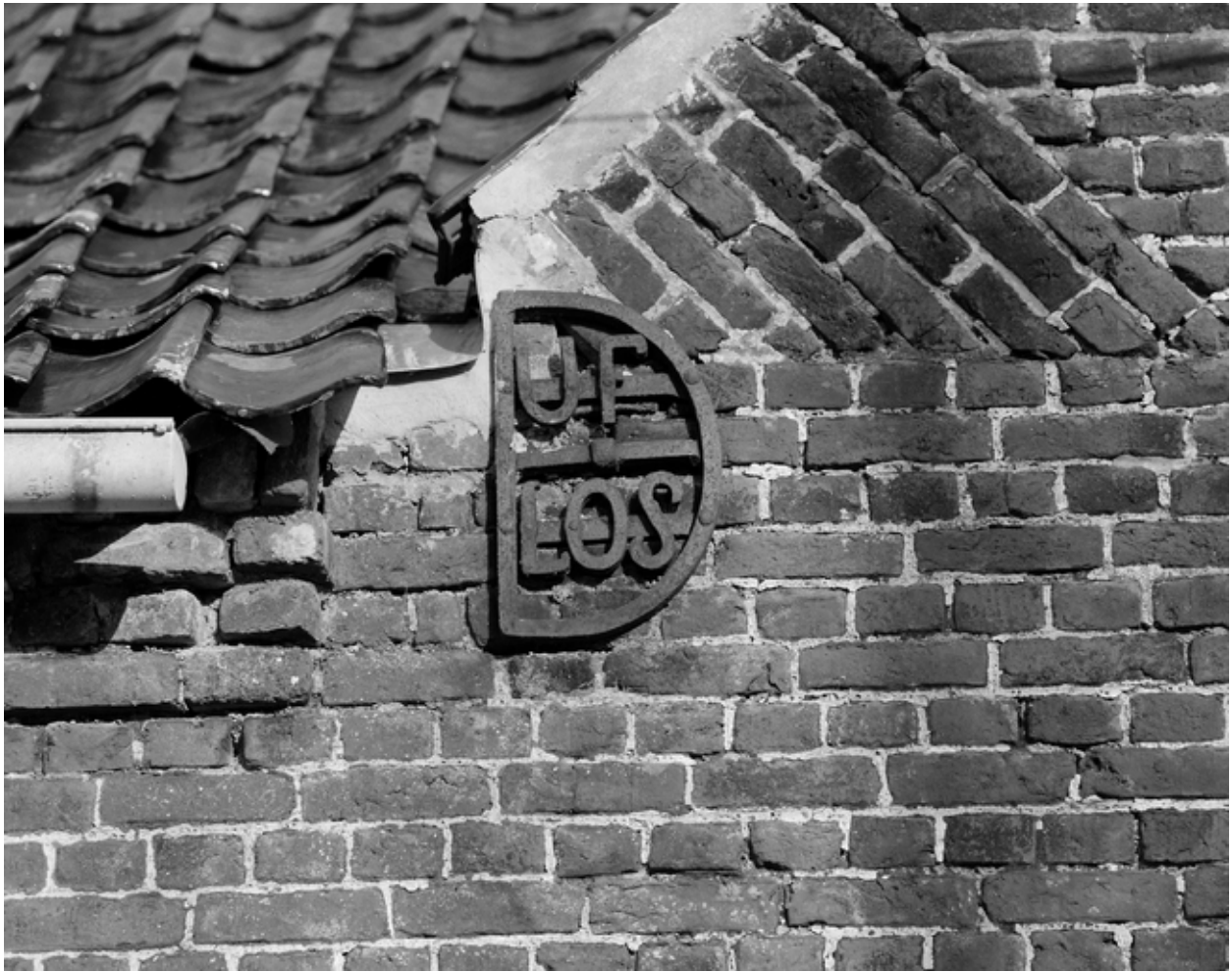
Détail du pignon des étables : fer d'ancrage patronymique Duflos.
