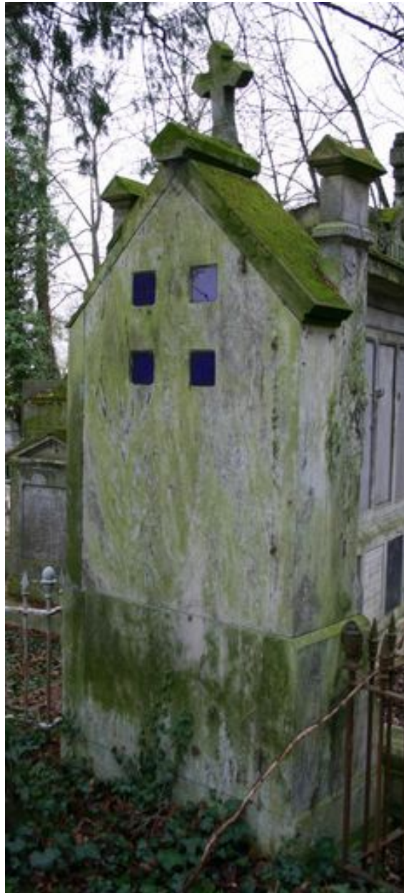
Tombeau en forme de niche monumentale, face postérieure.
