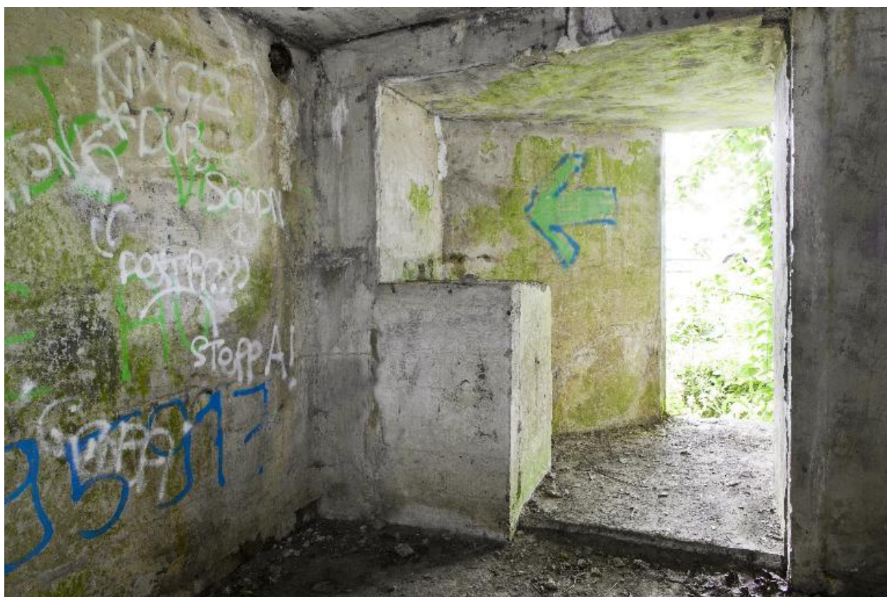
Salle nord. Vue vers l'entrée.
