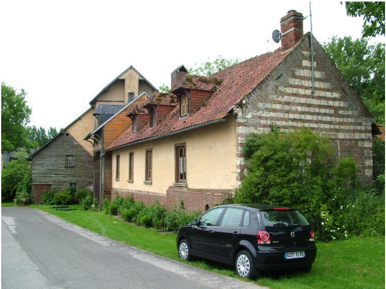
Vue du logis, rue du Moulin, au nord de la parcelle.
