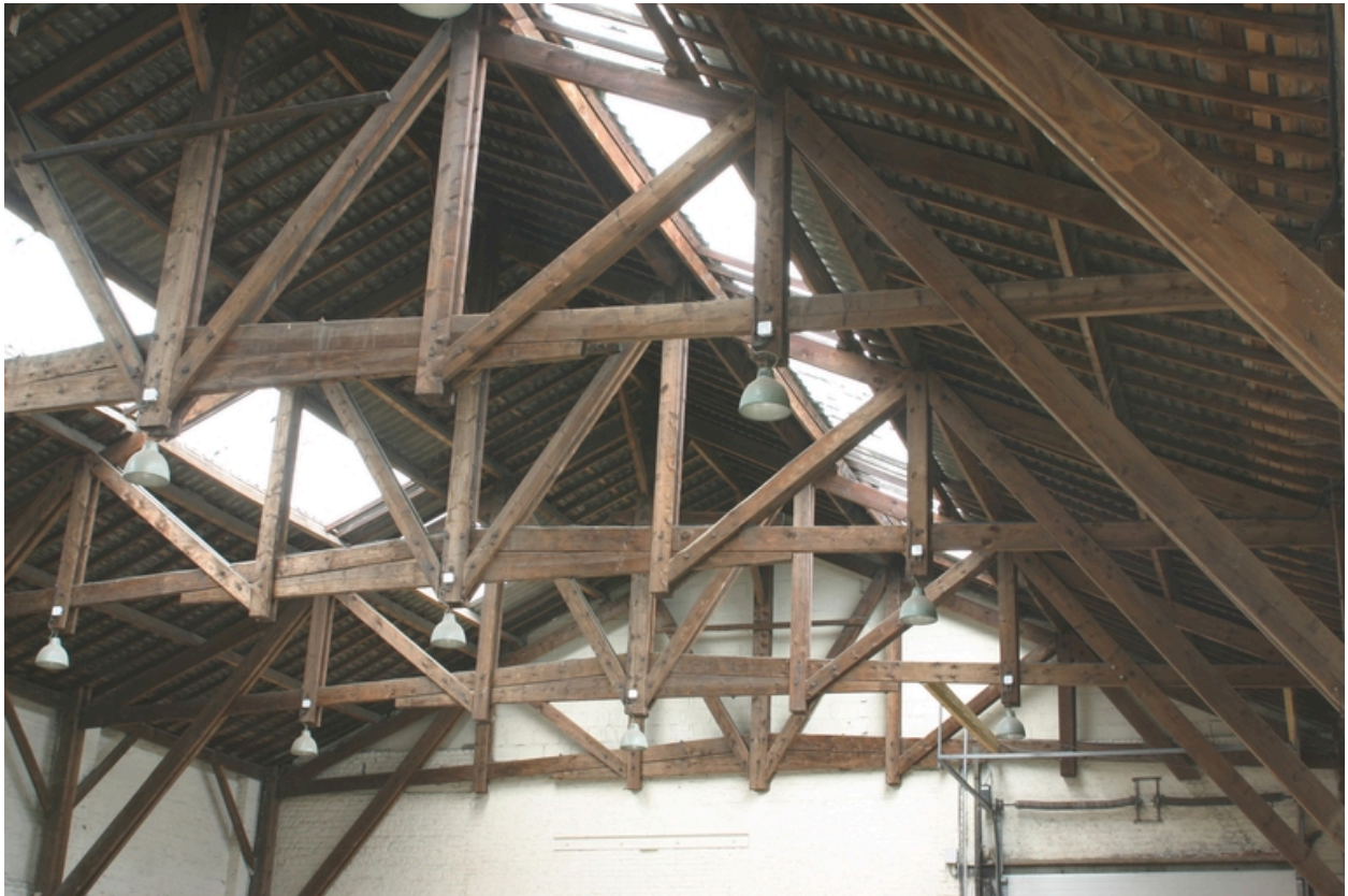
Charpente du hangar construit en fond de parcelle, rue Varlet.
