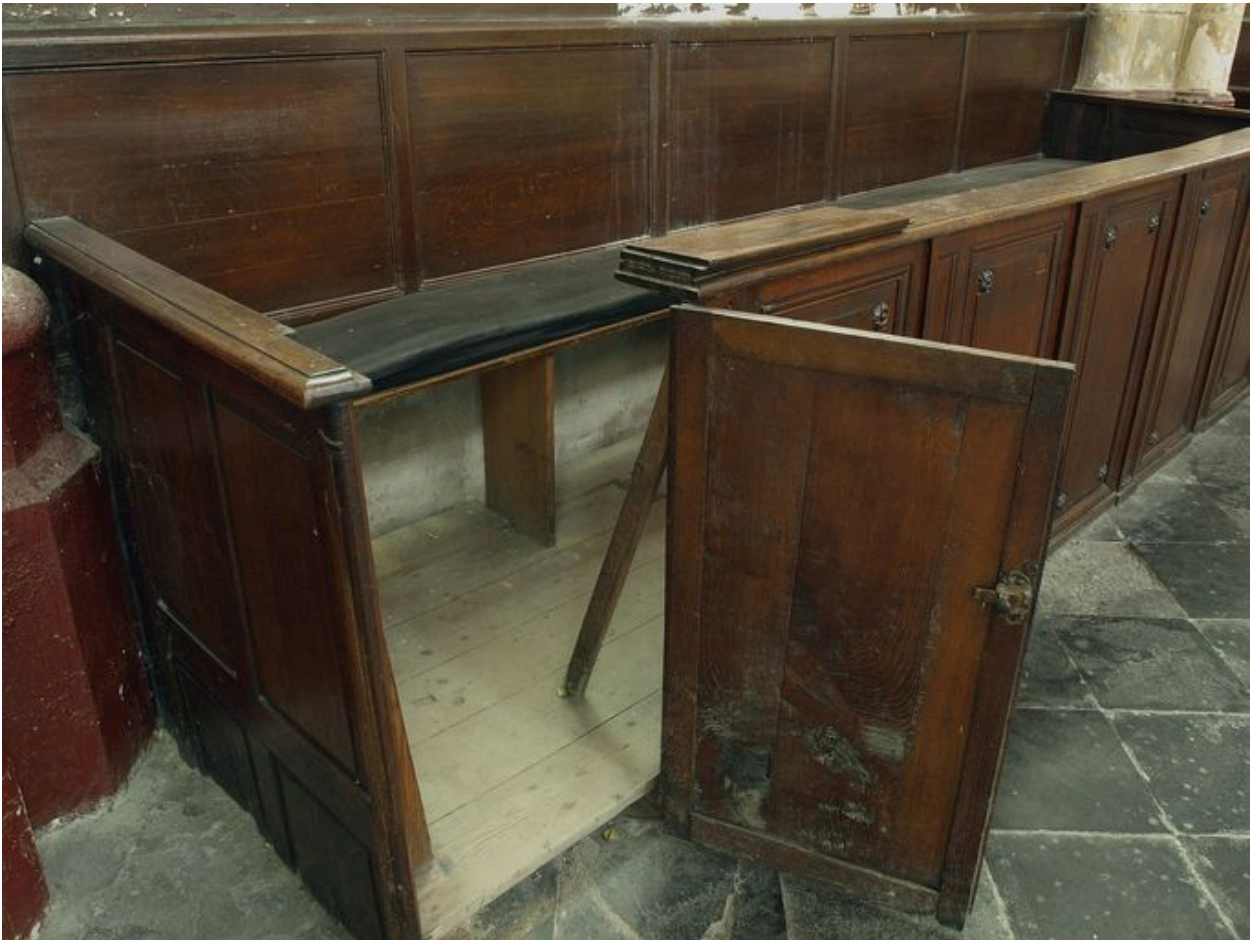
Un des bancs sud, porte ouverte
