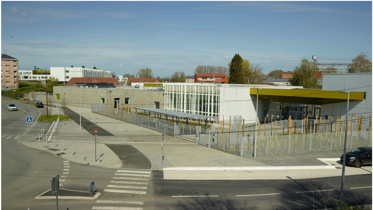
Nouvelle entrée : vue cavalière depuis le rempart, 2018.
