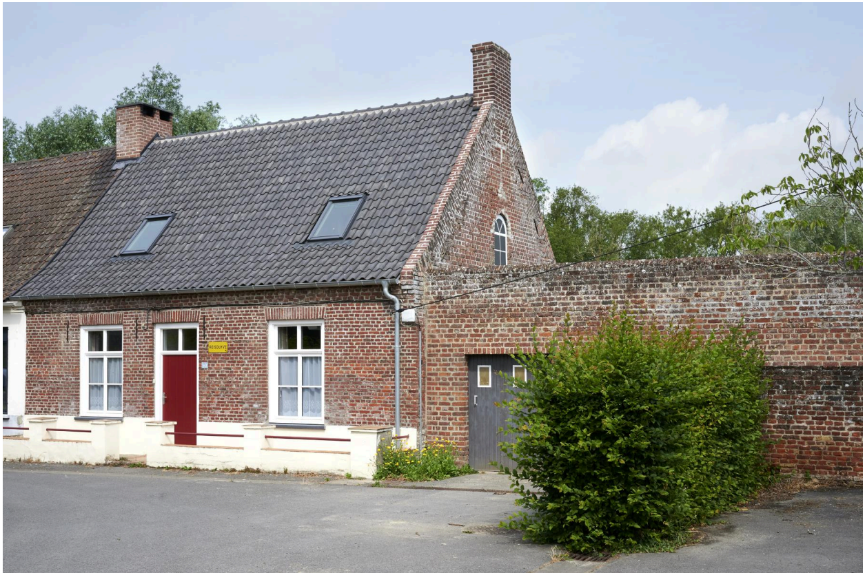
L'ancienne école, façade sur rue.
