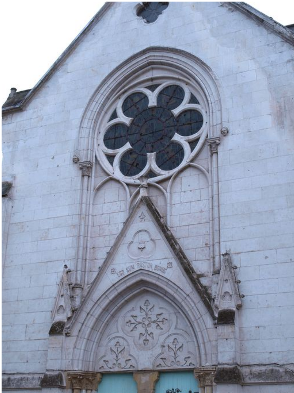
Pignon de la façade principale
