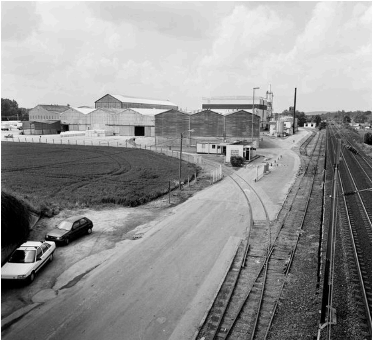
Vue d'ensemble nord.
