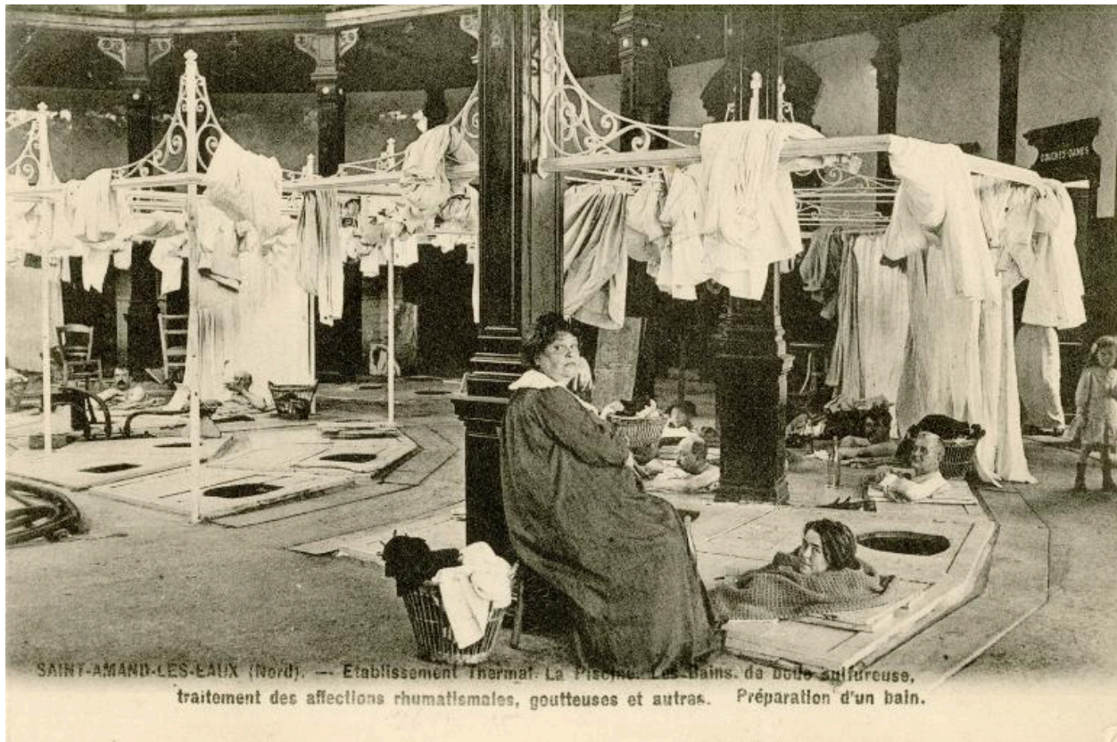
L'intérieur de la rotonde des boues, carte postale (Médiathèque Saint-Amand-les-Eaux).
